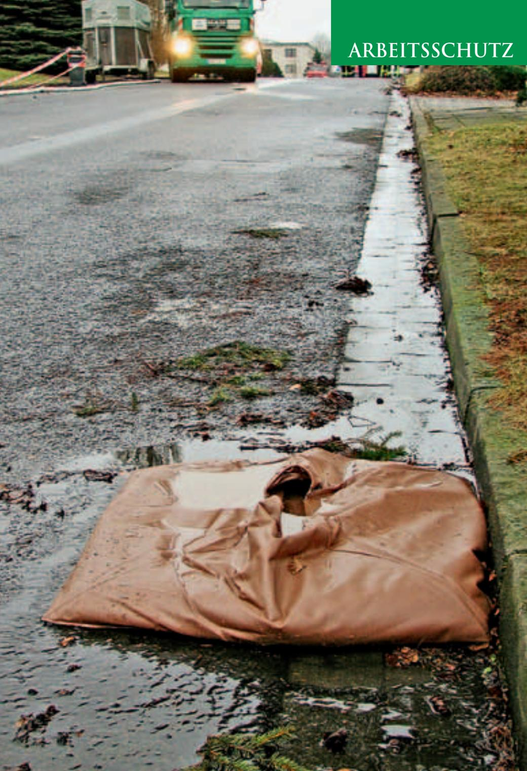
Abb. 1: Abdichtung von Regenwassereinflüssen auf einer Verkehrsfläche sollten auch bei Bioölnfällen rasch erfolgen, da auch Bioöle im Gewässer zum Erstickungstod der Gewässerlebewesen führen.
