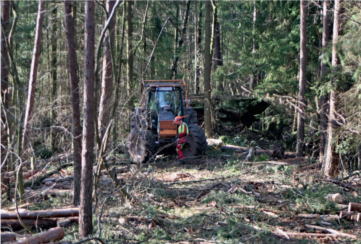
Abbildung 2: Aufgrund der Festlegung eines erweiterten Rückegassenabstandes durch den staatlichen Auftraggeber wird die motor-manuelle Zufällung notwendig, was im Ergebnis eine nicht gerechtfertigte Inkaufnahme eines hohen Unfallrisikos bedeutet.
