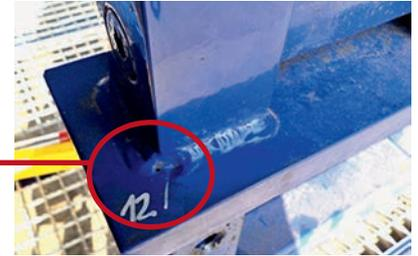
Abb. 2: Haltebock mit Vergrößerung einer unzureichenden Schweißnaht
